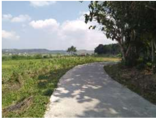
Gambar 5. Jalan Karangjati Kasongan Sumber : Dokumentasi
