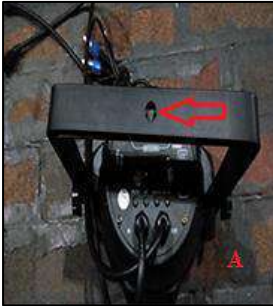
Gambar 217. Pemasangan C-clamp
