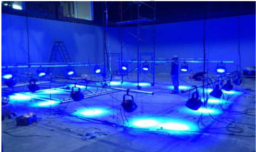
Gambar 241. Pemasangan PAR LED 120 pada Setiap Rigging (Doc Arya. 2015)
