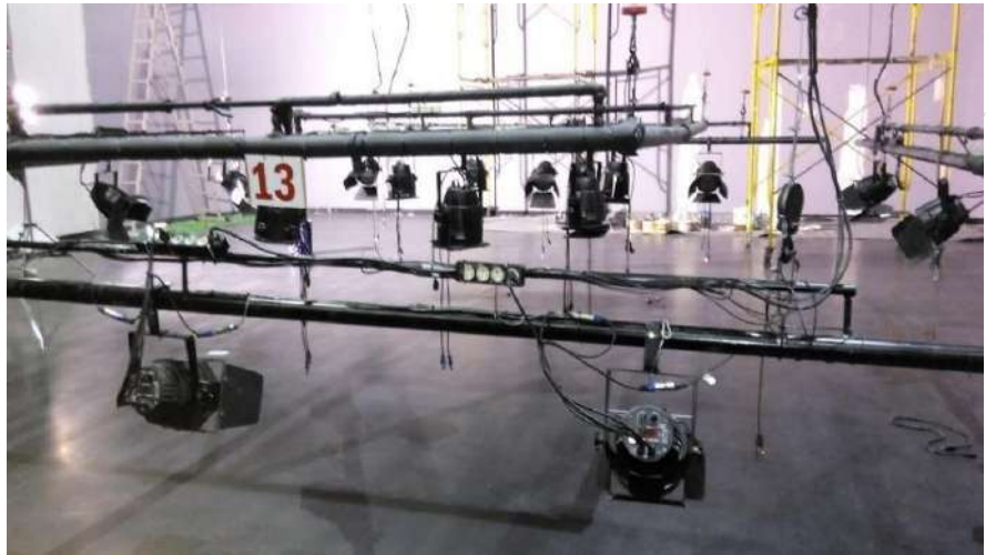
Gambar 240. Pemasangan Lighting Basic pada Setiap Rigging (Doc Arya. 2015)
