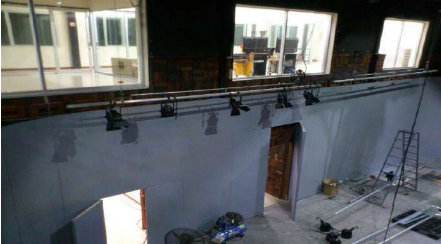
Gambar 238. Rigging no. 1 dan 2 yang Belum Seluruhnya Dipasangi Lighting (Doc Arya. 2015)
