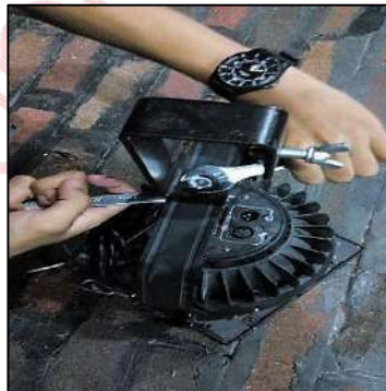
Gambar 226. Pengencangan Baut + Mur
