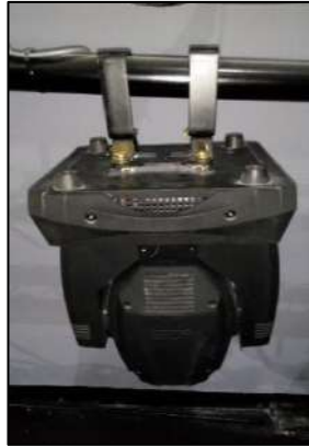
Gambar 233. Pemasangan Lighting pada Rigging (Doc Arya. 2015)
