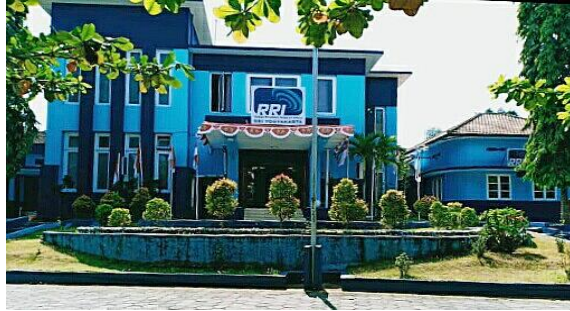
Gambar 1. Gedung RRI Pro 1 Yogyakarta
