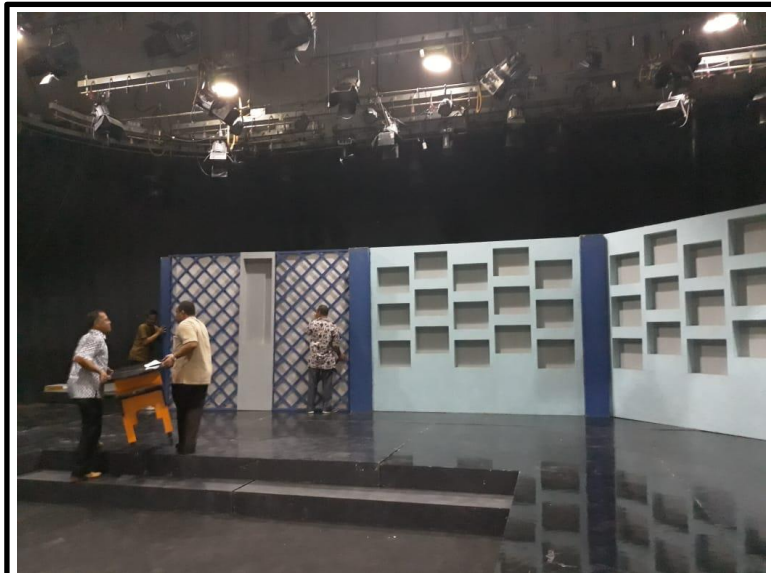
(Gambar 4.10 : Pemasangan Dinding Program Acara “Teknotani”)
