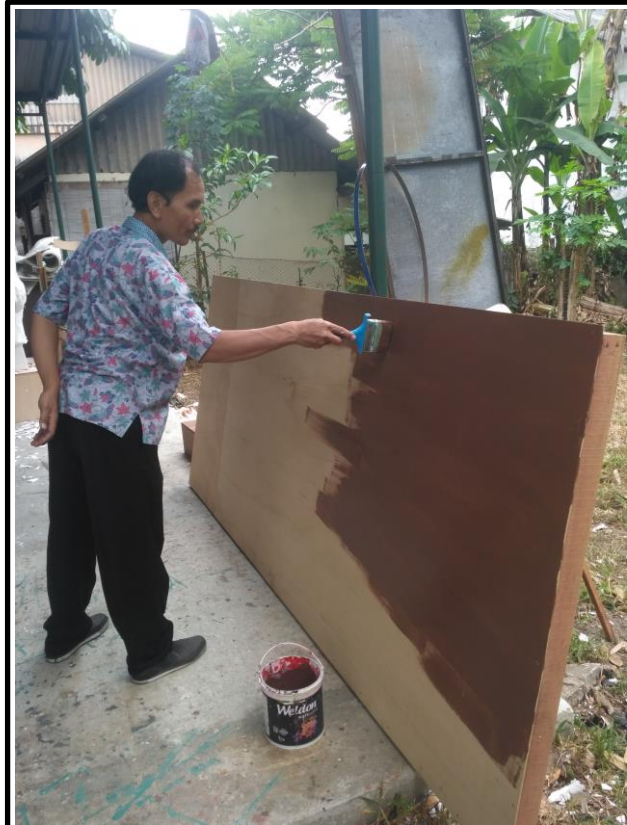
(Gambar 4.11 : Proses Pengecatan)
