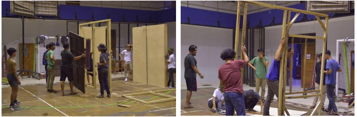
Gambar 4.6 Foto Pengerjaan Setting Building
