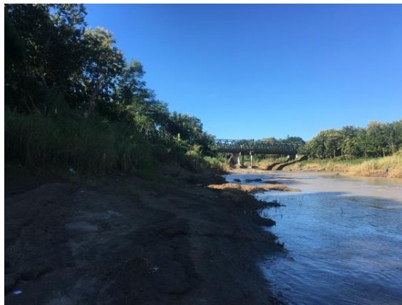
Gambar 03. Lokasi Sungai Siluk Sumber : Dokumentasi Pribadi
